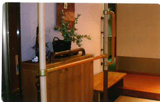
〈玄関での設置例〉
